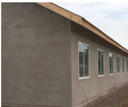
Het nieuwe klaslokaal van de Kambarage secondary school
